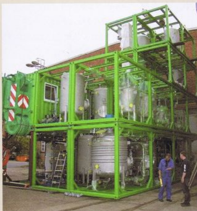
カナダのプラント建設中のもよう。写真提供：アルファカット
